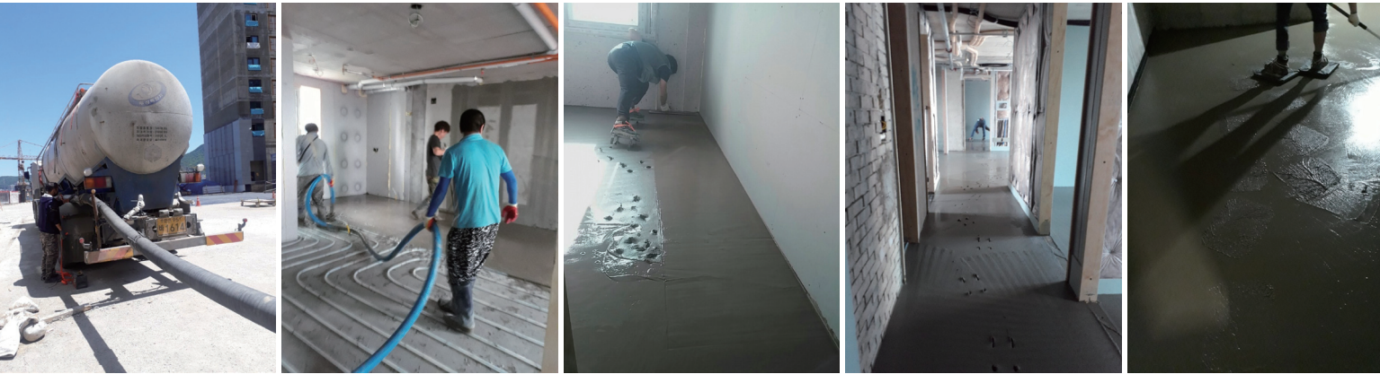
모르타르(모래+시멘트+물) 공급부터 시작하는 바닥 미장. 10~12시간 정도 작업해 여름엔 오후 5~6시, 가을과 겨울엔 밤 9~10시에 끝났다.(사진:필자 제공)
