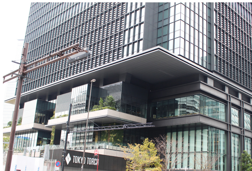
미쓰비시지소가 야심차게 선보인 도쿄의 도키와바시타워. 38층의 초고층빌딩이다.
